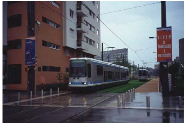
Einfügung einer Straßenbahn in einer bei Baubeginn freigehaltenen Strecke, hier in Grenoble.
